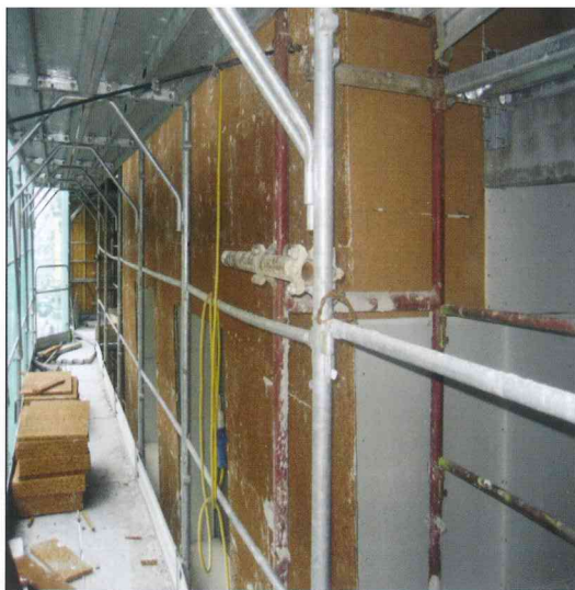
Particolare del rivestimento a cappotto BioVerd in sughero biondo naturale sulla superficie delle lastre in cemento rinforzato applicate sulla sottostante struttura metallica a protezione termo-igrometrica della facciata ventilata inclinata. Sopra il rivestimento in sughero BioVerd è stato eseguito un intonaco di spessoramento KoMalt.G e successiva fase realizzativa della decorazione in rilievo tridimensionale con finitura in cemento fibrorinforzato.
