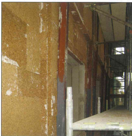
Particolari del rivestimento eseguito con pannelli in sughero biondo superkompattato SoKoVerd.LV applicato alla parete interna con adesivo a presa rapida PraKov. In una seconda fase si è realizzato l'accoppiamento di una struttura metallica per la formazione della facciata ventilata inclinata.
