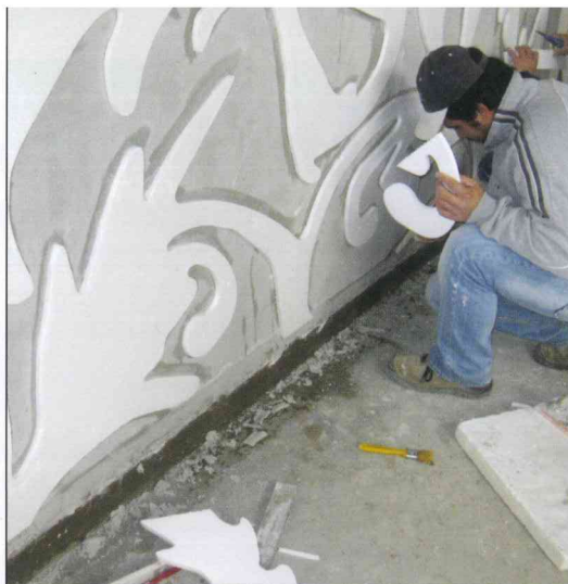
Particolare del rivestimento a cappotto BioVerd in sughero biondo naturale sulla superficie delle lastre in cemento rinforzato applicate sulla sottostante struttura metallica a protezione termo-igrometrica della facciata ventilata inclinata. Sopra il rivestimento in sughero BioVerd è stato eseguito un intonaco di spessoramento KoMalt.G e successiva fase realizzativa della decorazione in rilievo tridimensionale con finitura in cemento fibrorinforzato.
